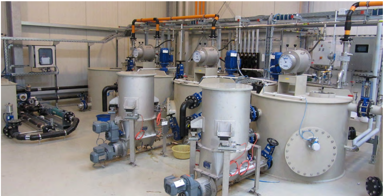
Biogasanlage im Technikum, Lehr- und Forschungszentrum :metabolon
