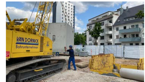
Brunnenbohrungen für die Geothermie-Anlage: Der Brunnen-schacht wird zur Baugrube geführt.
