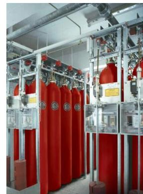
*Hochdruck-Gasflaschen einer Kohlendioxid-Löschanlage*
