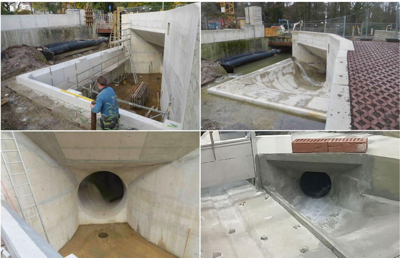
**Bild 8:** Errichtung des Trennbauwerks: Fertig gestellte Überlaufkante und Einlauftrög (oben) sowie Vergleich Einlauftrompete in Natur und Modell (unten)
