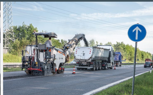
Ausbau kompletter Fahrbahnen
