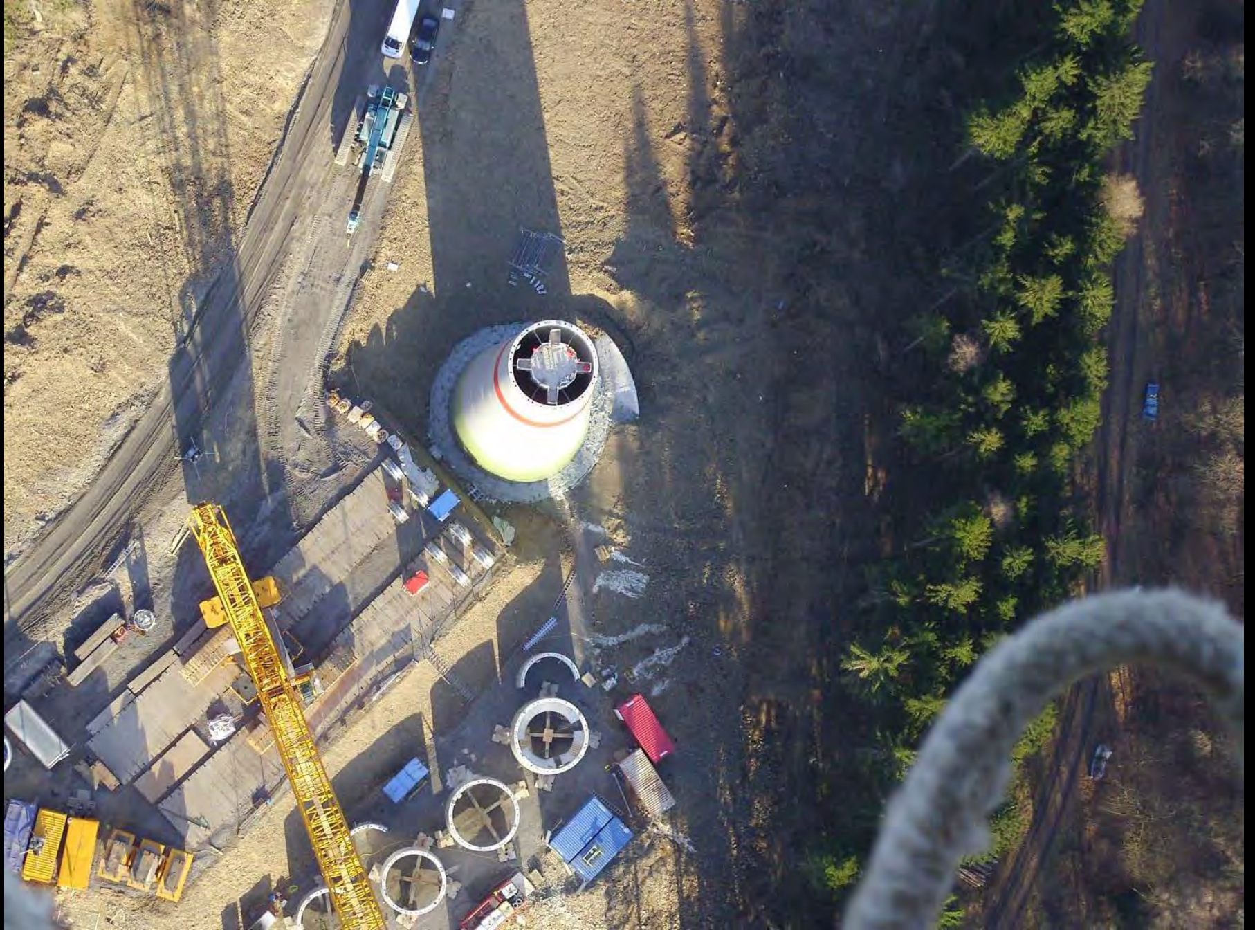
Turm mit Arbeitsbühne von oben
