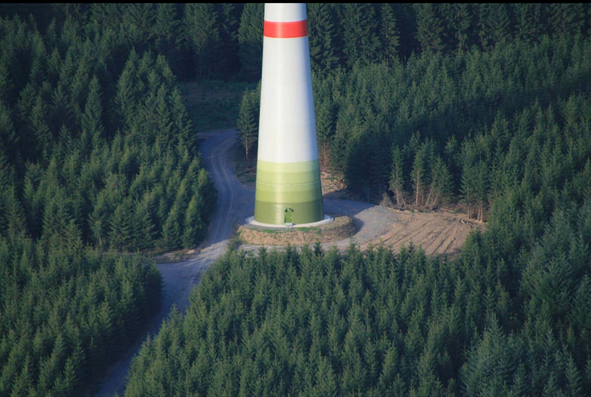
Bürgerwindpark Hilchenbach – dauerhaft entwaldete Fläche: 1,5 ha
