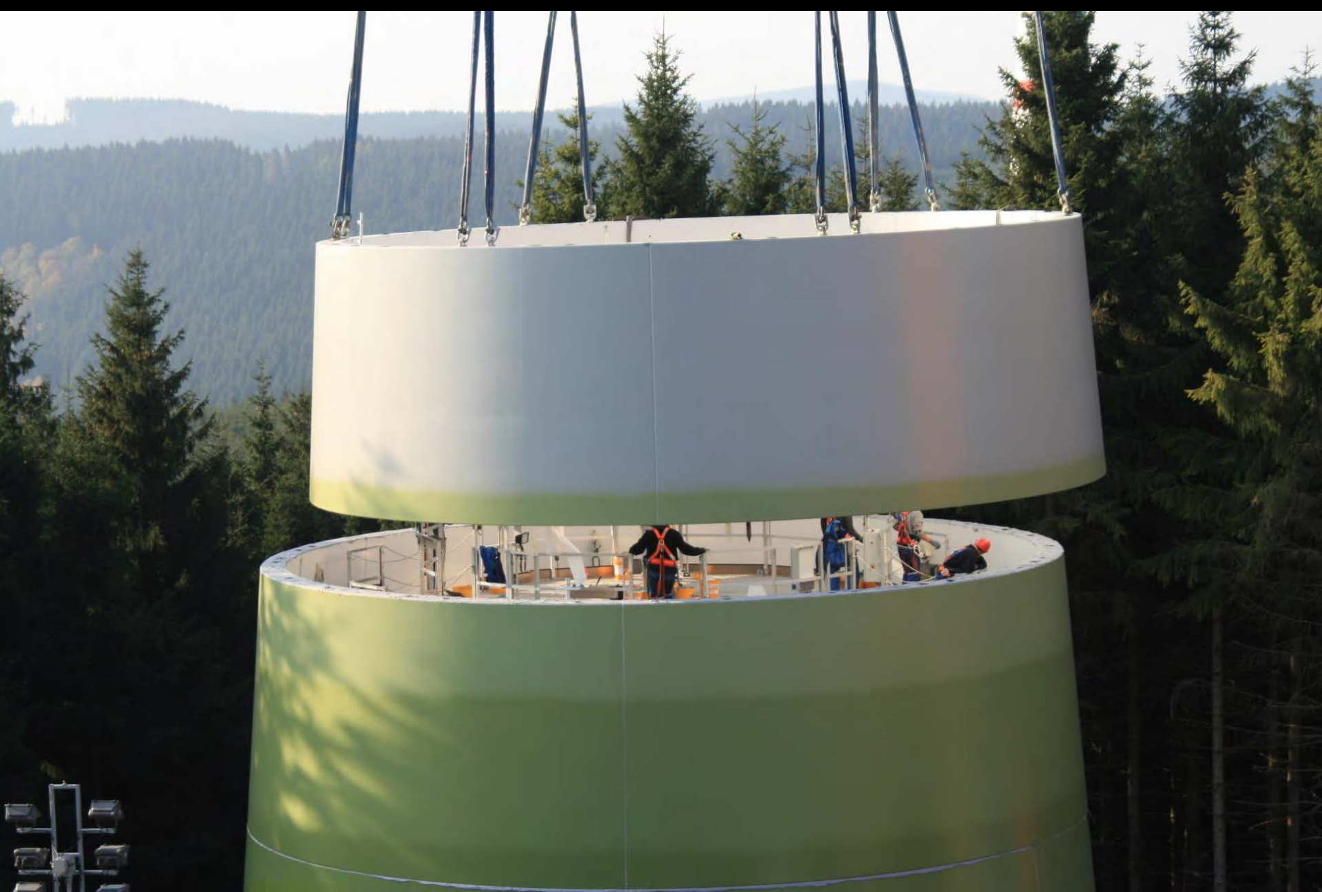
Ein Ringsegment wird gesetzt
