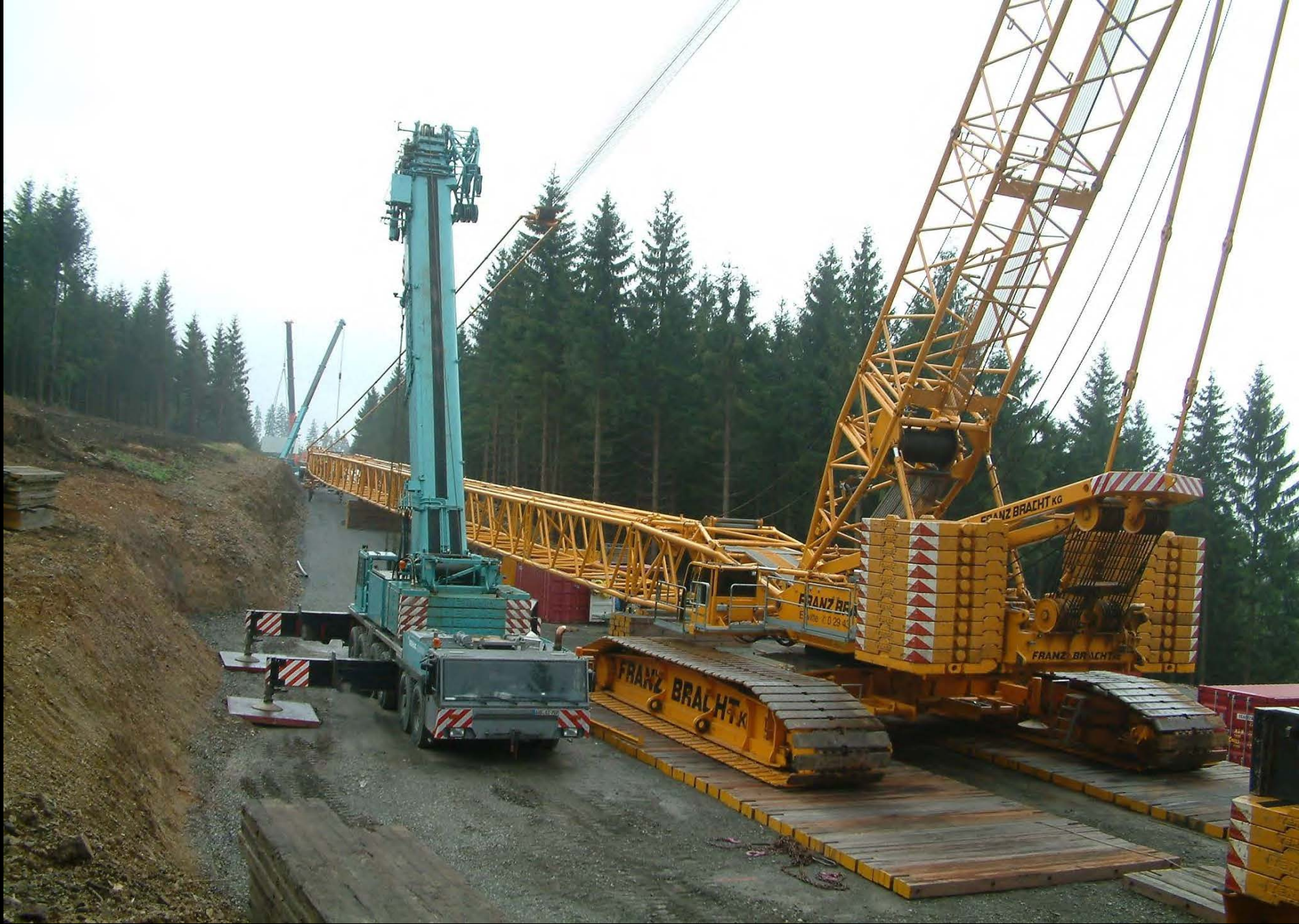
DEMAG-Kranraupe und „Servicekrane“
