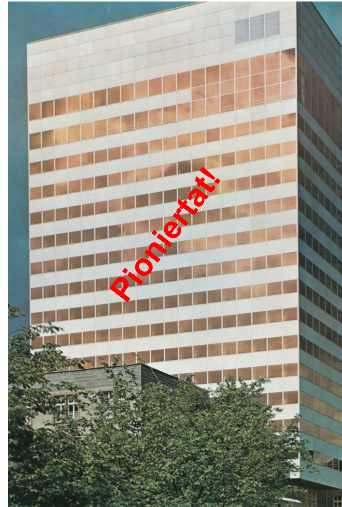
Eine der 1. S.-Schutz-Verglasungen in der BRD, Kreisverwaltung GM; Gold 40/26 Lichtdurchlässigkeit (TL): 40% Gesamtsonnenenergiedurchlass (g): 26% Selektivitätskennzahl: TL/g
