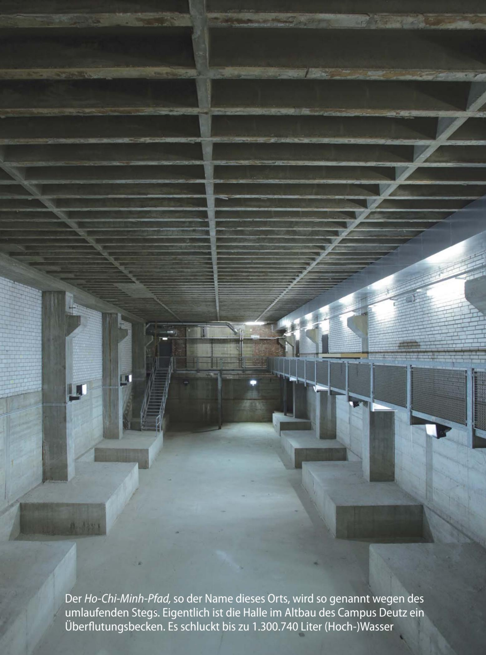
Der *Ho-Chi-Minh-Pfad*, so der Name dieses Ortes, wird so genannt wegen des umlaufenden Stags. Eigentlich ist die Halle im Altbau des Campus Deutz ein Überflutungsbecken. Es schluckt bis zu 1.300.740 Liter (Hoch-)Wasser
