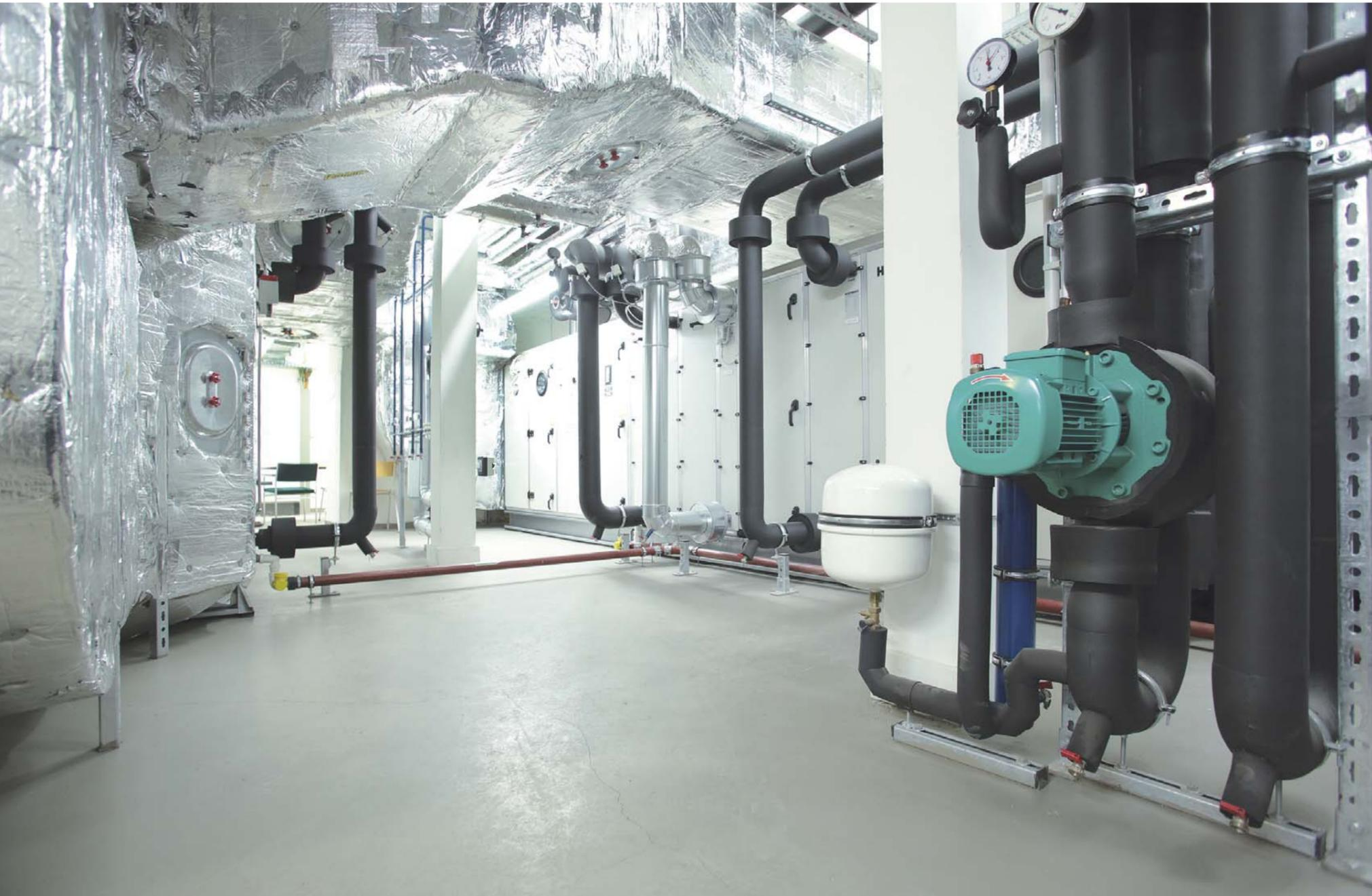
Diese Raumlaufttechnik- und Lüftungsanlage in der Claudiusstraße (oben) versorgt den Hörsaal 69 und drei Seminarräume. Für Fachkundige: Die Lüftungsanlage hat eine Zu- und Abluftleistung von 15.000 m<sup>3</sup>/h, eine maximale Kälteleistung von 119,40 KW und eine maximale Wärmerückgewinnung von 76,80 KW
