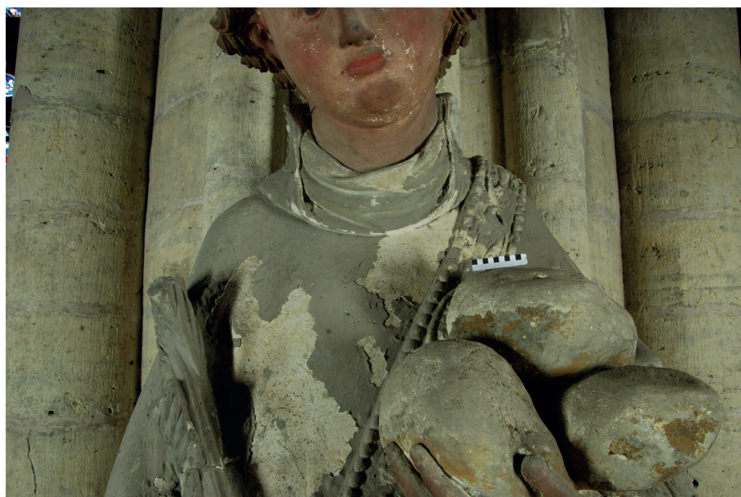
Abb. 6: Großflächiger Fassungsverlust und instabile Fassung am Beispiel eines der beiden Kirchenpatrone (Hl. Stephanus)
