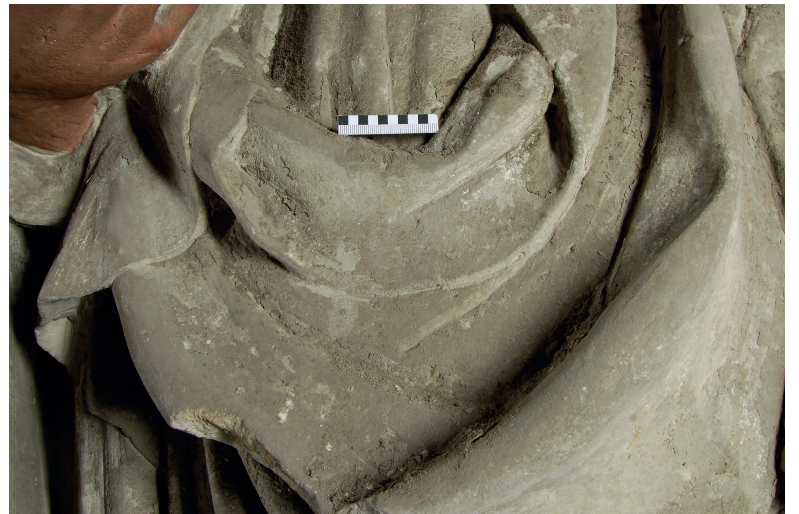
Abb. 7 und 8: Zustand vor und nach Abnahme der Schmutzauflagen im Bereich einer Gewandfalte
