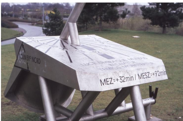
Abb. 3 Das zweite geneigte Zifferblatt auf der Konsole der Sonnenuhr.
