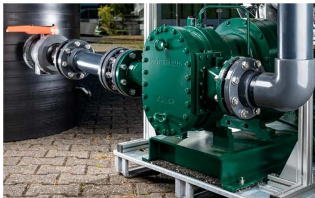
Korthaus Drehkolbenpumpe KD152 in einer Gülleverwertungsanlage
