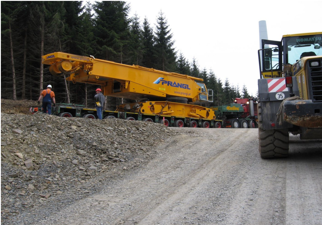
Anlieferung des 800 t - Raupekranes
