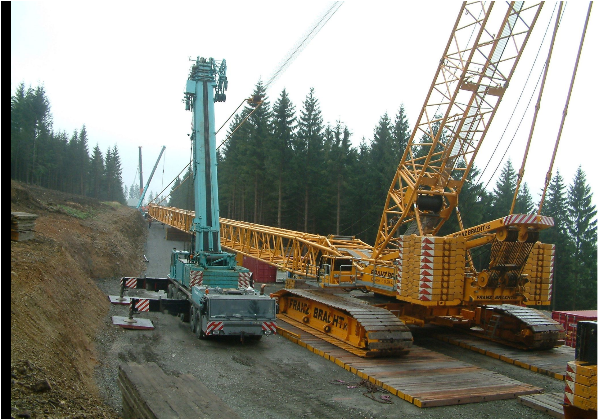
DEMAG-Kranraupe und „Servicekrane“
